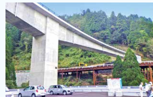
付替県道7号橋
