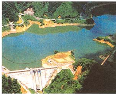
ダムの規模 堤高 63m 総貯水容量 11,300千m 3
